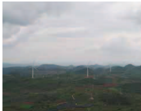
▲ 云南丘北老庄科风电项目
