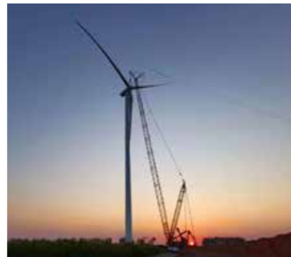
▲ 山西大蛇头风电项目风机吊装
