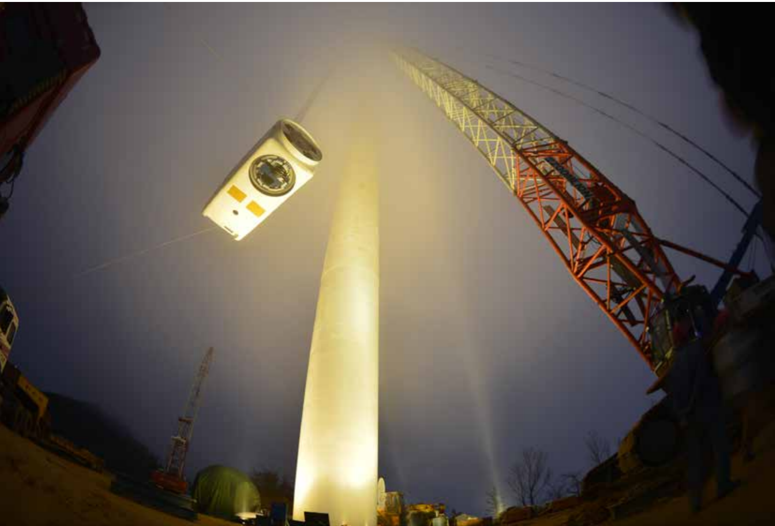
▲ 涟源龙山风电项目吊装
